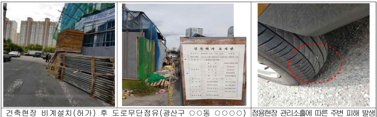
[사진 4] 일시점용허가와 다르게 무단 점용 및 원상복구 미이행
