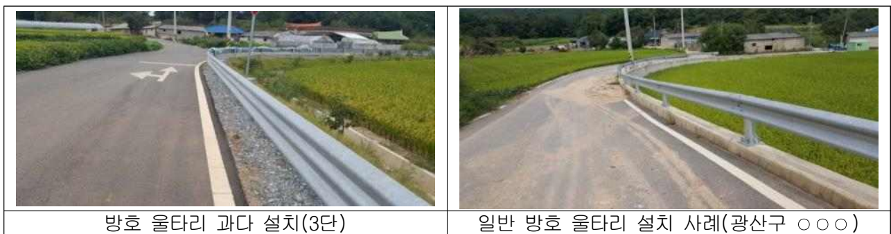
[사진2] 노측용 방호 울타리 설치현황
