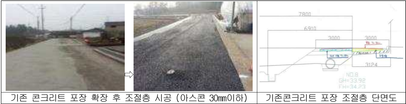
[사진1] 마을진입로 확포장공사 포장 조절층 시공 현황
