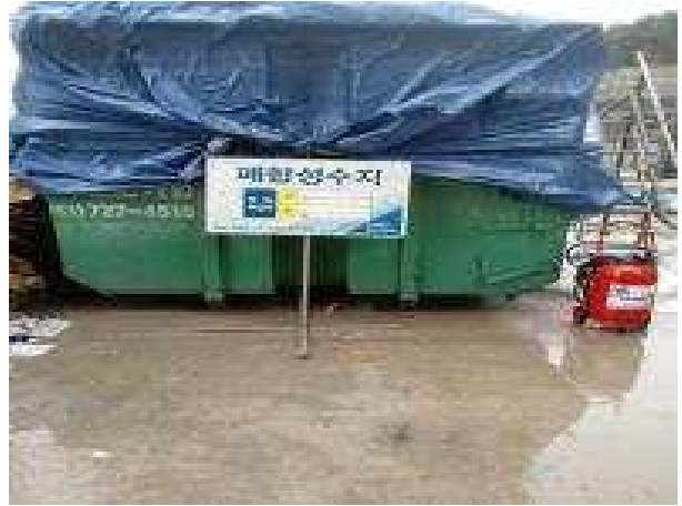
후 : 덮개 설치(즉시 조치)
