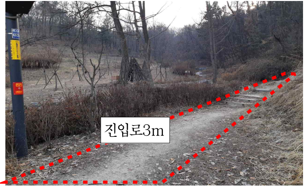
▲ ☆☆동 산183 제형돌수로 설치 현장
