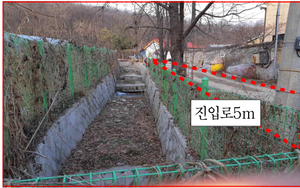
▲ ○○동 489-2 깎돌기습막이 설치 현장
