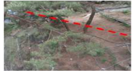
그림 낙석방지망 보조앵커 미설치
