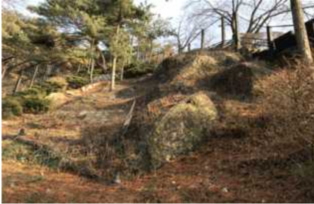
▲ 고장력 낙석방지망 설치 현황
