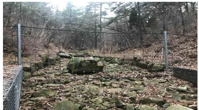
▲ 고강도 유연성네트 설치(길이 15m, 높이 3m)
