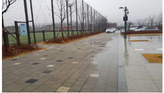
▲ 노면 침하부분에 물고임 발생
